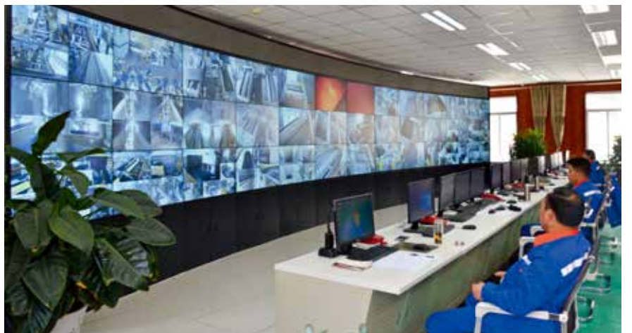
祁连山水泥生产调度系统
