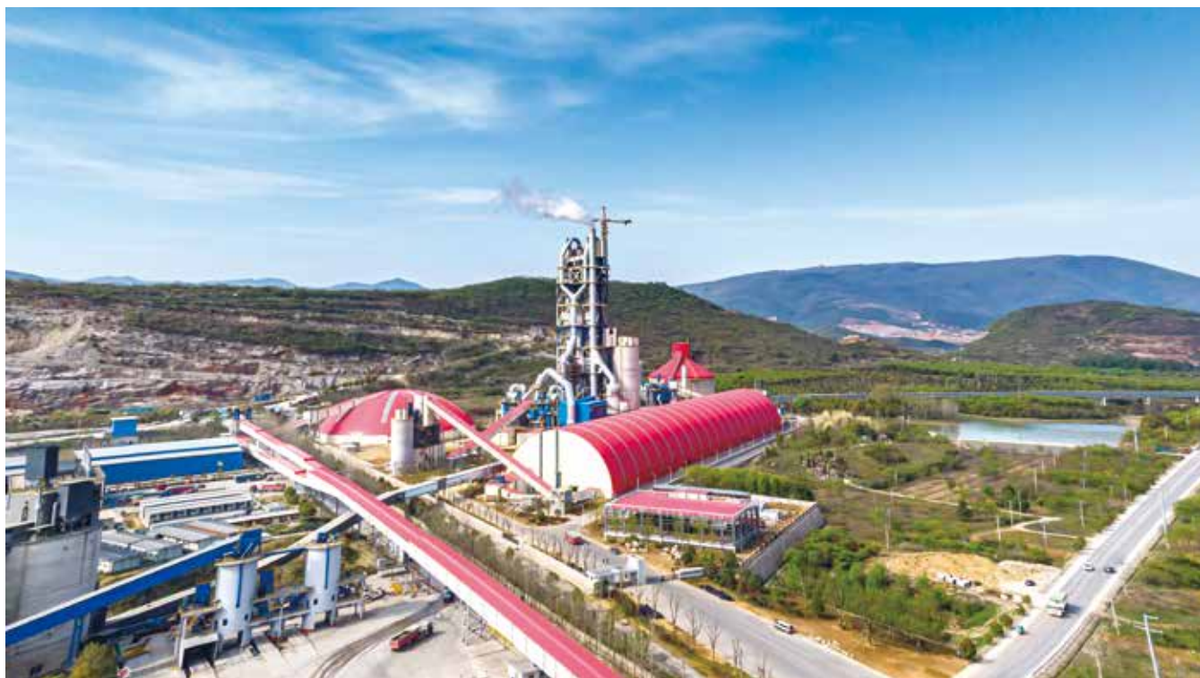
槐坎南方日产7500吨优化升级项目全景
