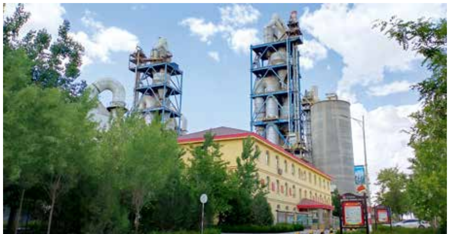
太阳山分厂中控楼
